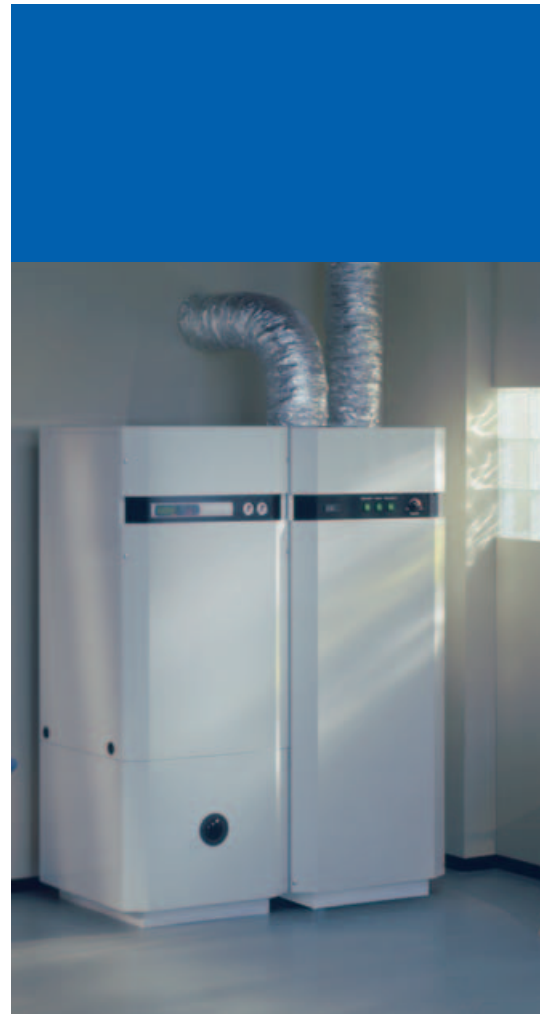
Logafix Sole/Wasser-Kompakt-Wärmepumpe WPS 90 IK mit Pufferspeicher und Brauchwasserabluftwärmepumpe
